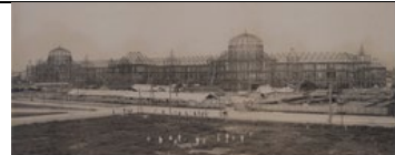
中央停車場(東京駅)建築写真 1911年(明治44)
